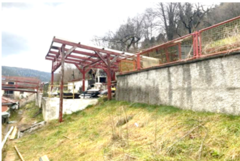
Foto 5 des SV: Überdachung im nordöstlichen Grundstücksbereich
