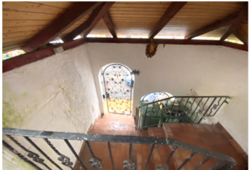
Foto 7 des SV: Überdachter Treppenaufgang
