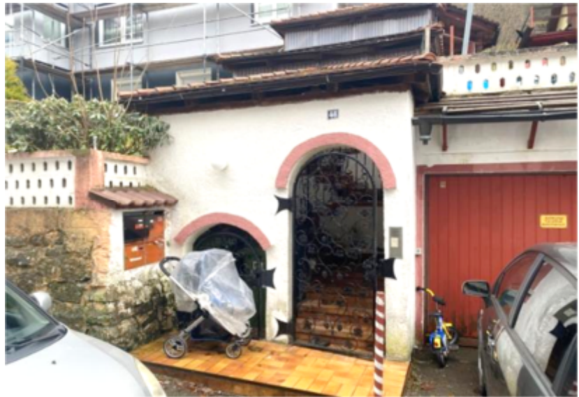
Foto 6 des SV: Grundstückseingang
