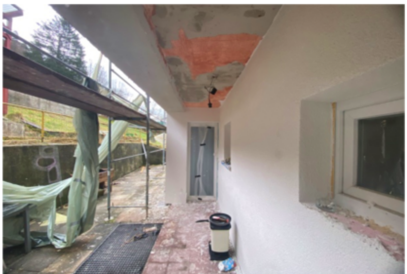
Foto 14 des SV: EG, Loggia/Terrasse
