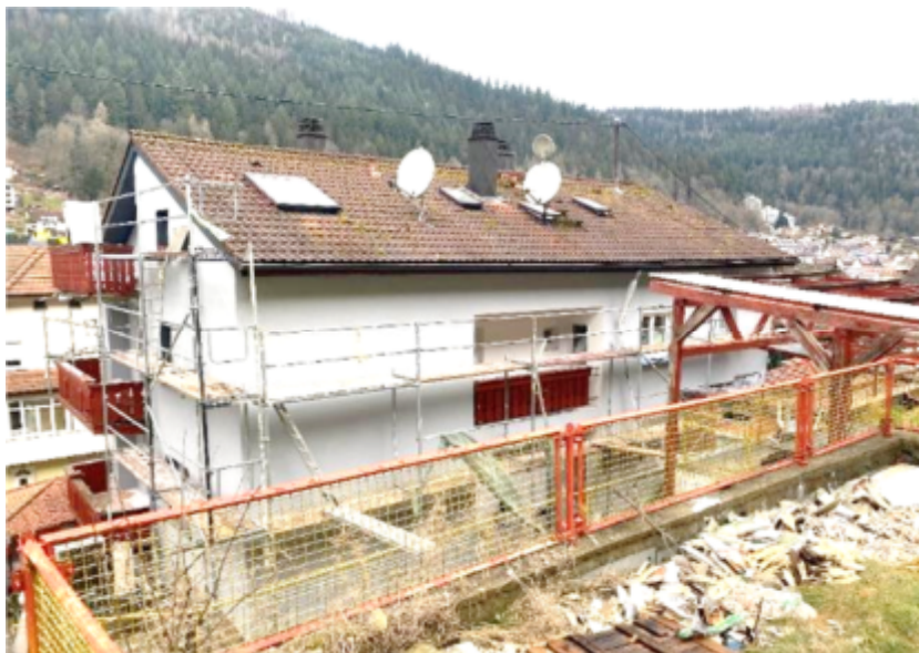
Foto 3 des SV: Ansicht von Südosten, Hausrückseite
